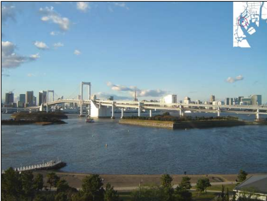
Photo 5 : Le pont Rainbow Bridge qui enjambe le port de Tôkyô. Au centre les batteries côtières Daiba. En premier plan la plage artificielle. En arrière plan la tour de Tôkyô. © Scoccimarro 2007
