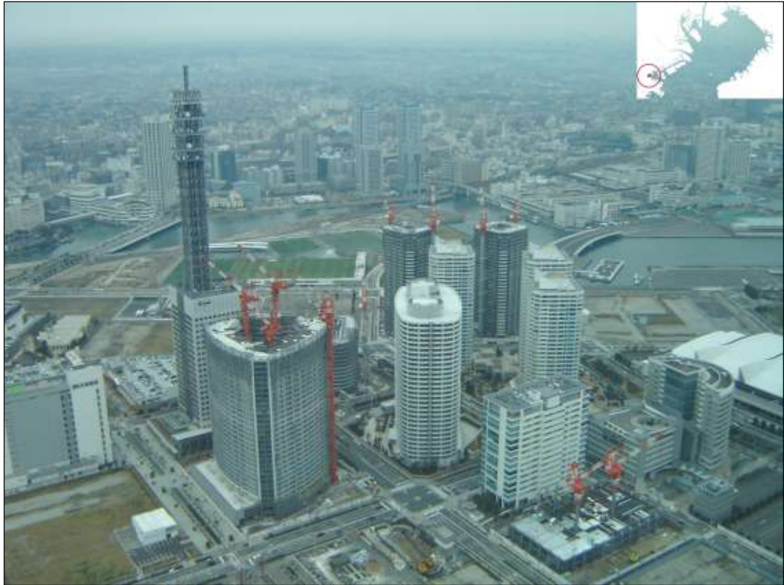
Photo 21 : Forêt de kôsô manshon en cours de construction sur Minato Mirai 21 zone centrale. © R. Scoccimarro 2007.
