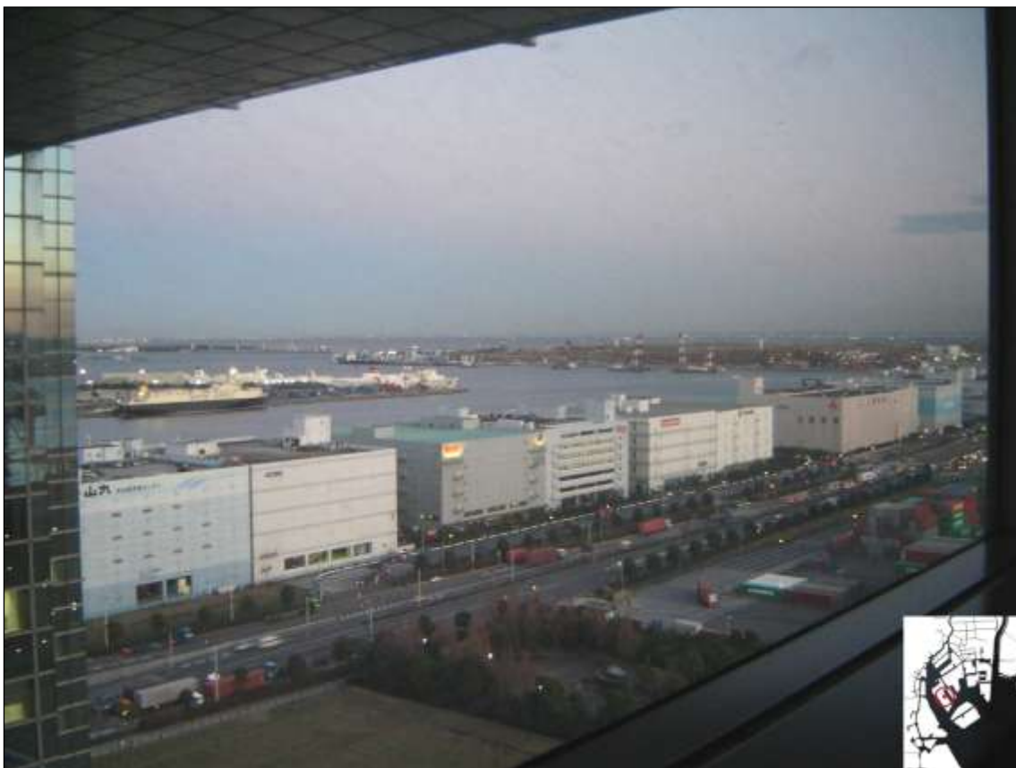
Photo 41 : Les derniers terre-pleins du Brise Lame Interne (arrière plan à droite) vue depuis le Telecom Center. Au premier plan entrepôts et quais pour conteneurs au sud du Rinkaifukutoshin. © Scoccimarro 2007.
